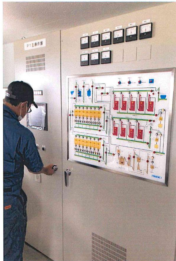
乾燥設備操作盤。当該操作盤とVPNルータを有線LANで接続。
